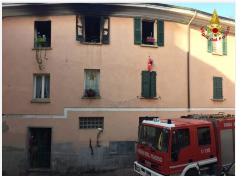
Lo stabile interessato dall'incendio
