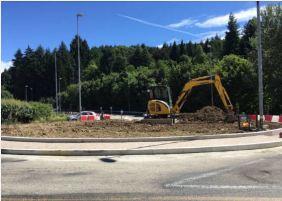
Conclusi i lavori per la nuova rotatoria di Induno Olona
