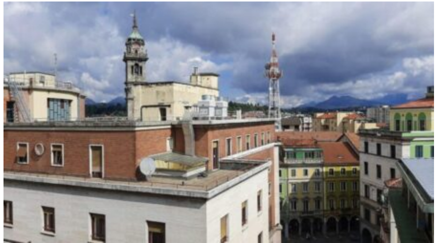
Il traliccio visto da un'altra zona della città
